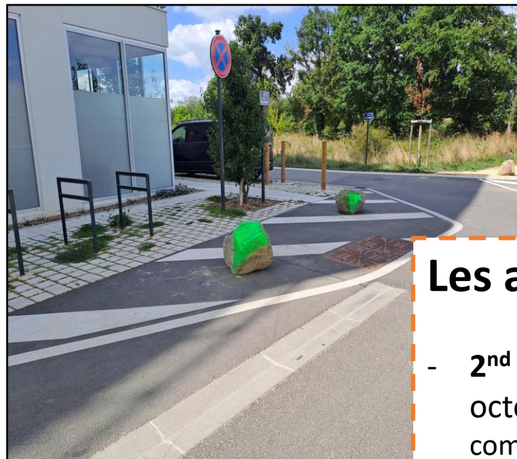
Exemple de mise en place contre stationnements gênants
